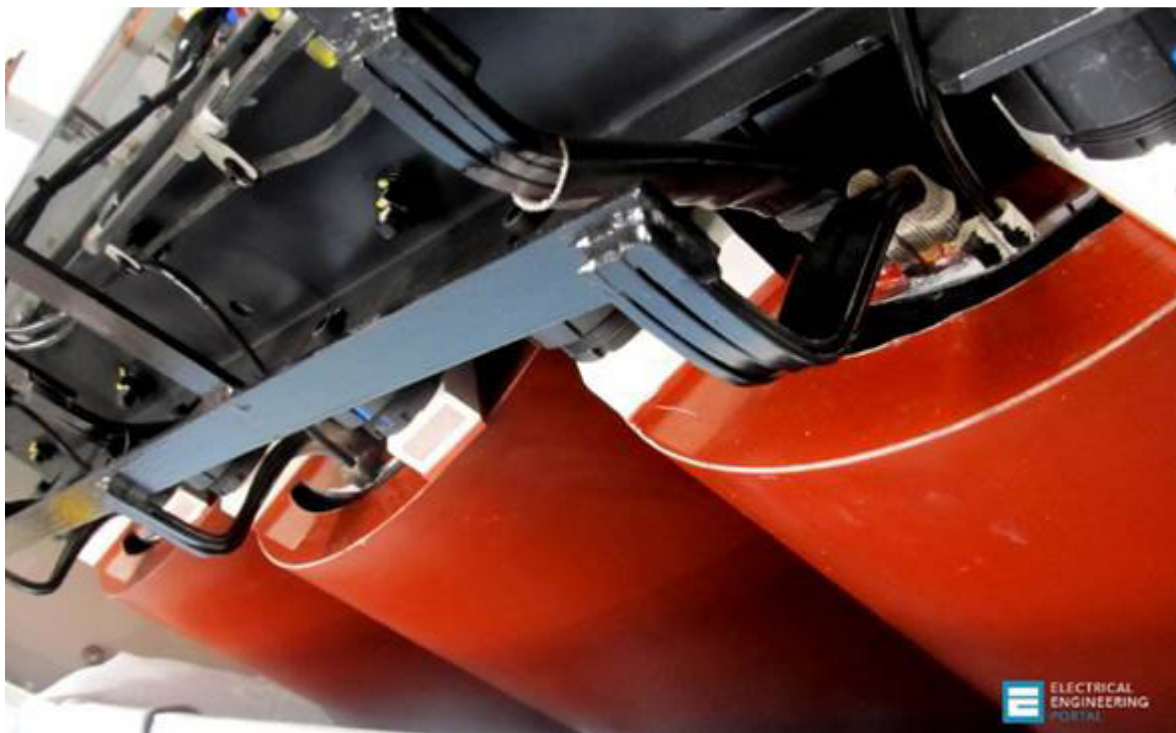
Lado de baixa tensão de transformador a seco. (fonte: eep.com)
